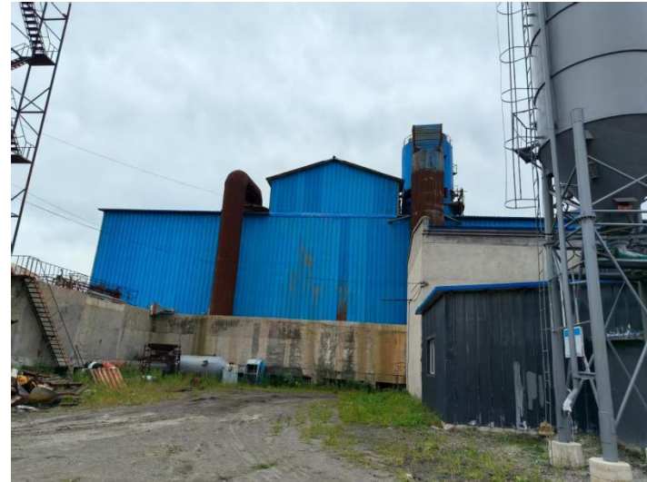
64MW 备用锅炉和 46MW 调峰锅炉锅炉房
