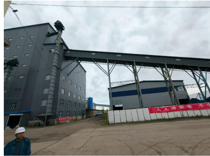
封闭式输煤栈桥（一）
