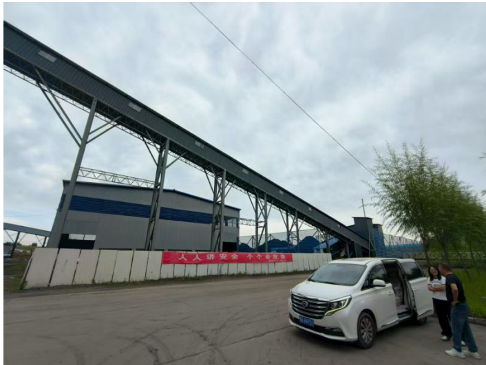
封闭式输煤栈桥（二）
