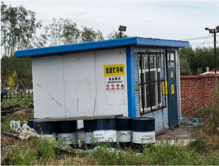
危险废物贮存库
